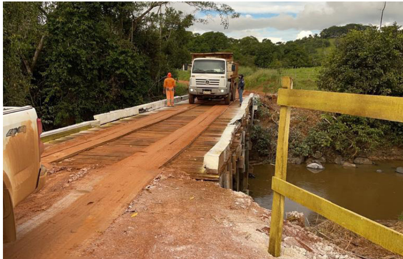
As equipes estão trabalhando para recuperar os danos causados pelas chuvas intensas neste período
